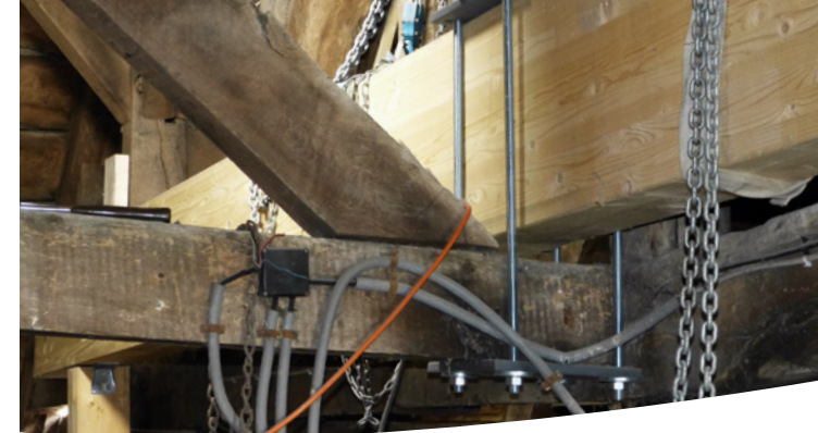
Entlastung des alten Balkenbestandes im Dachstuhl Kirchenschiff
